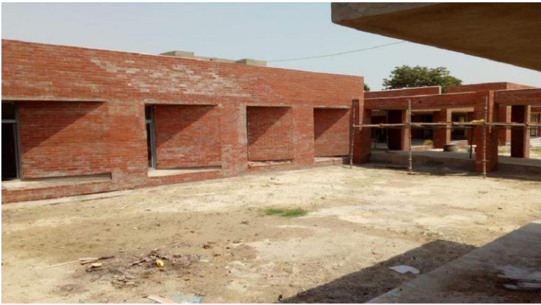
मुख्य भवन (प्रशासनिक खंड) – कोल्हुआ (वेशाली)
